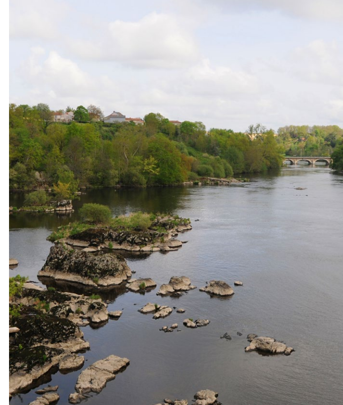
La Vienne en aval du barrage, avec le pont Saint-Sylvain à L'Isle-Jourdain en arrière plan.
