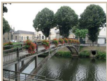
A Passerelle reliant le quai Victor Hugo au quai Poëy d'Avant
