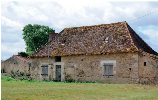
Bâti traditionnel à Laleuf, toiture à quatre pans couverte de tuiles plates.
