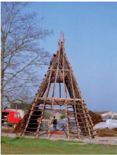
Hangar en construction, perches et traverses sont posées
