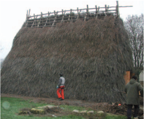
Hangar en construction, les paquets de brandes sont attachés de bas en haut
