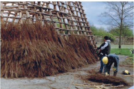
Hangar en construction, perches et traverses sont posées
