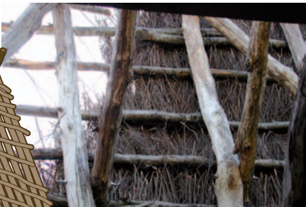
Hangar en construction, les perches constituent l'armature et les traverses, plus fines, permettent de consolider l'ensemble et d'accrocher les paquets de brande
