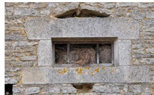
Ouverture d'un bâtiment agricole, avec arc de décharge.
