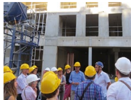
Visite de chantier par JJ. Pegot-Augier ©CIAP
