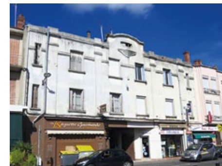
Immeuble rue A. Briand ©CIAP
