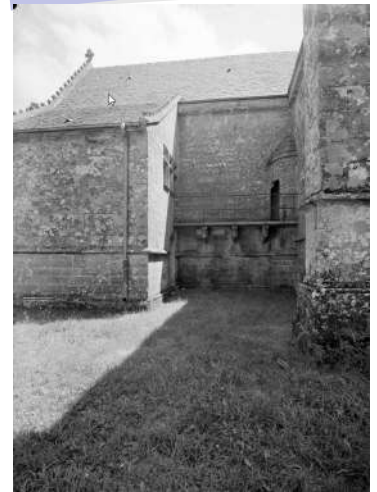
La coursière extérieure
