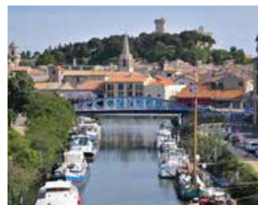
Le canal du Rhône à Sète
